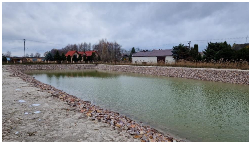
„Renowacja zbiornika wodnego w miejscowości Straszów" (Gmina Rozprza)
