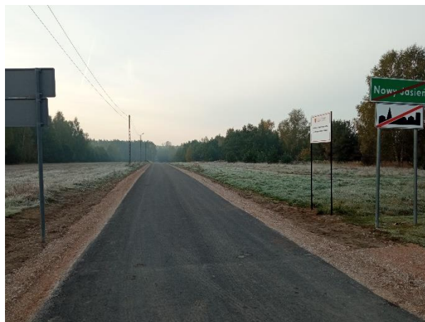
Droga dojazdowa do gruntów rolnych (Gmina Lubochnia)
