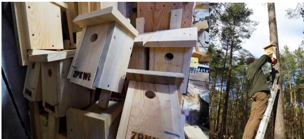
Wykonanie i montaż budek dla ptaków, ssaków i owadów
