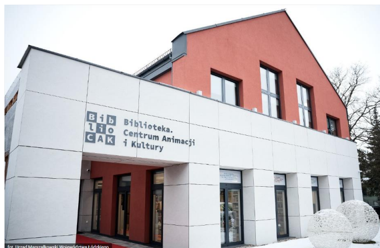
Budynek Biblioteki Gminnej
